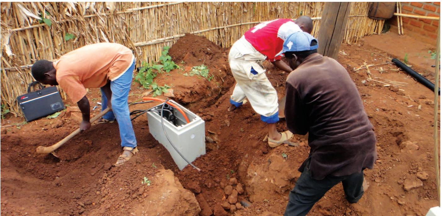
Unterirdische Stromkabel als Voraussetzung für Solarenergie in Namitete
