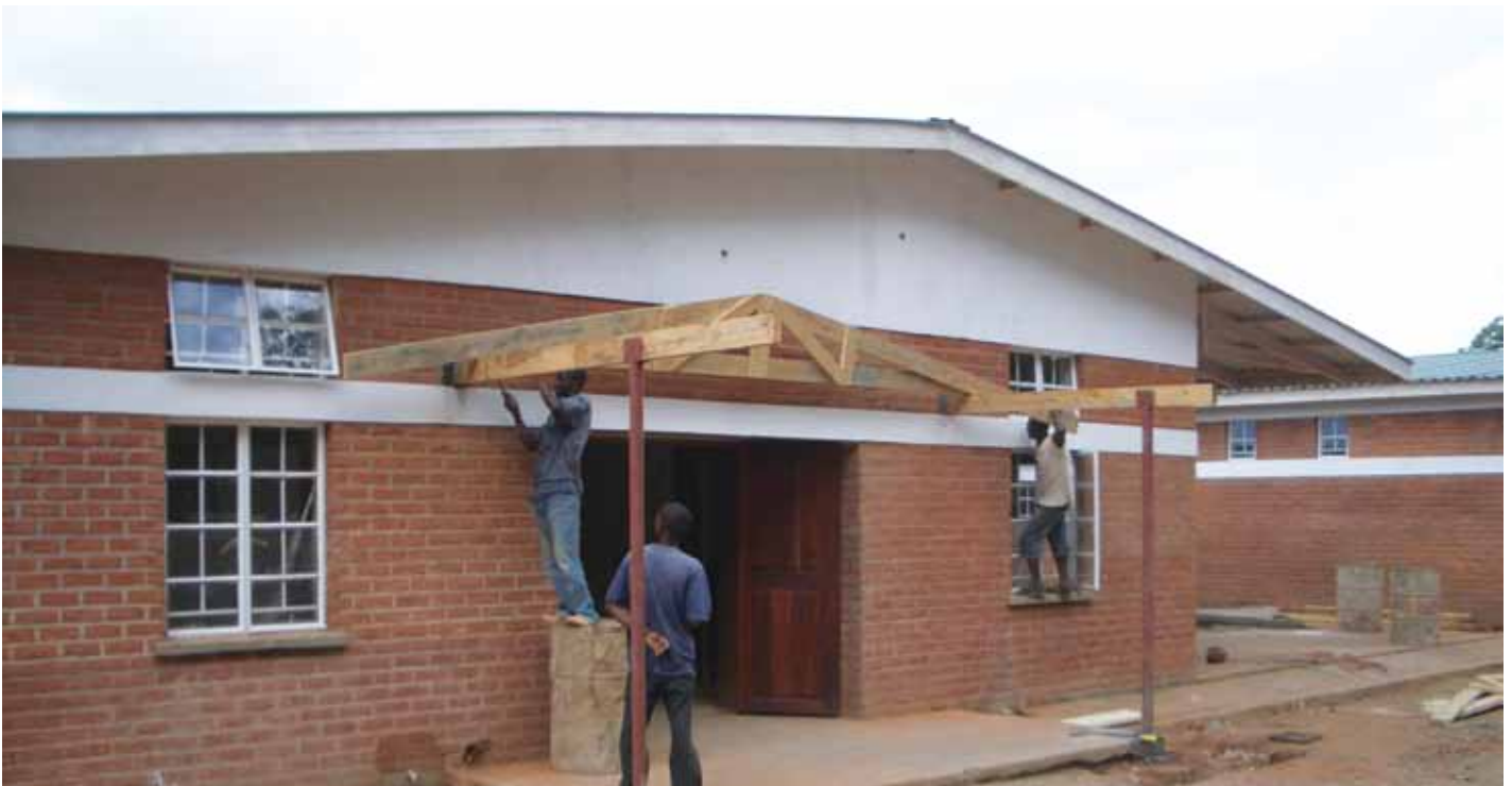
Das Outpatient Department (OPD) kurz vor der Fertigstellung
