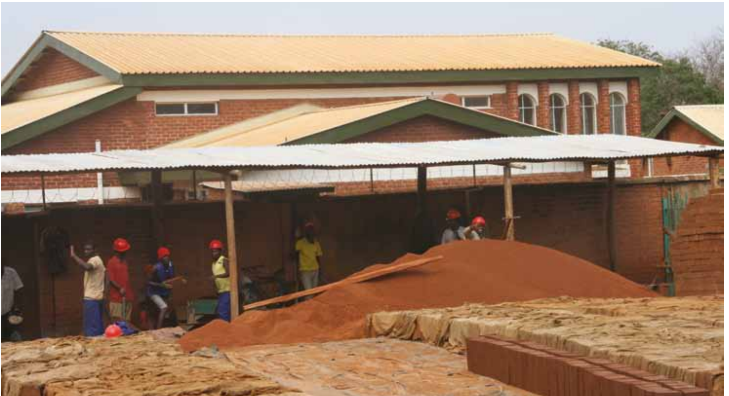
Die Steine für den Kindergarten werden auf der Baustelle produziert
