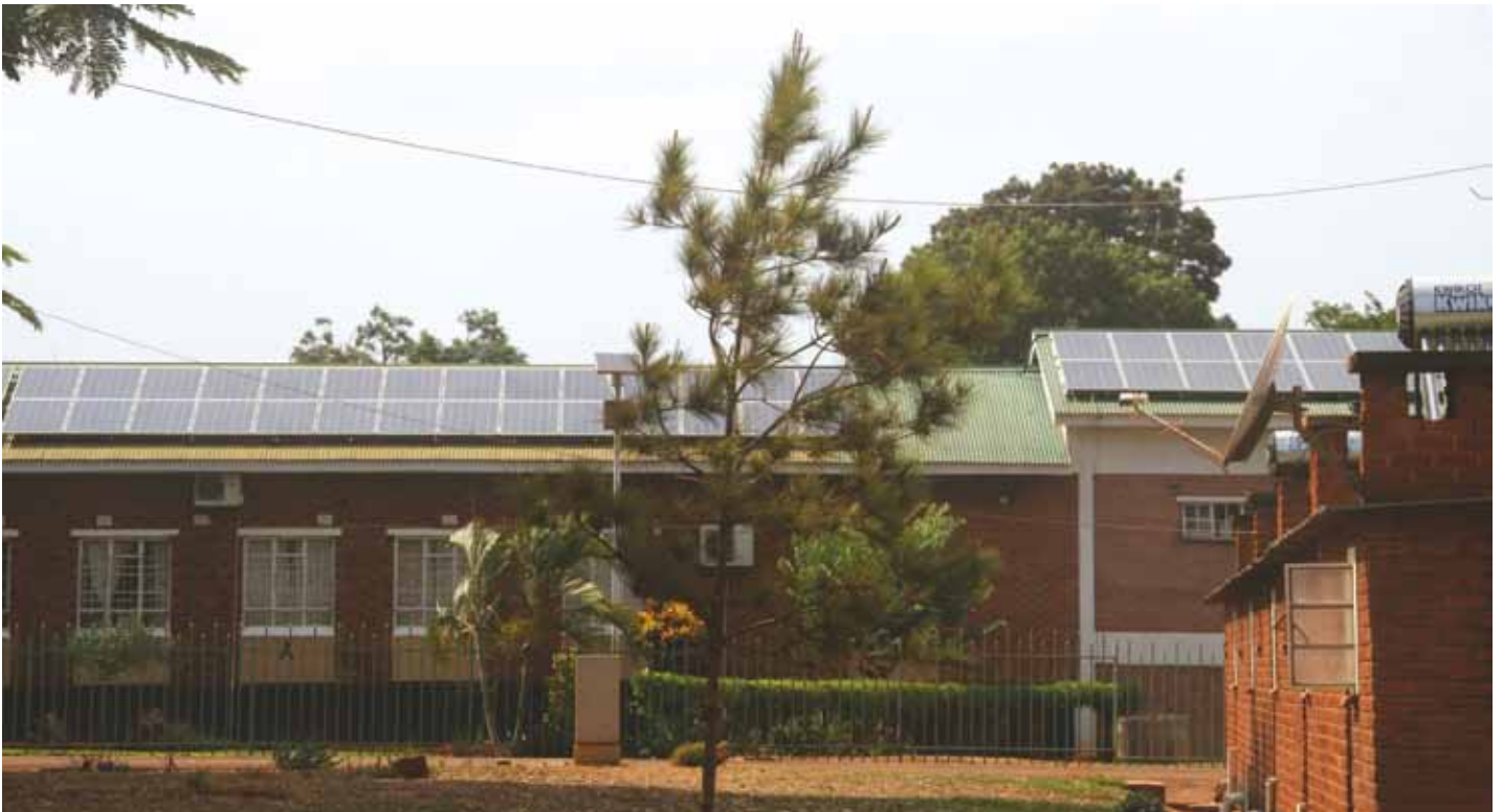
Die Solaranlage sichert den Betrieb des Krankenhauses bei ständigen Stromausfällen
