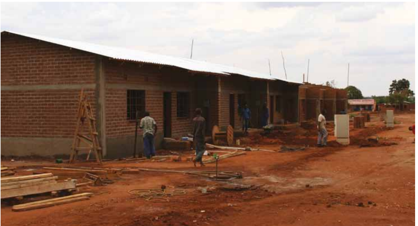
Neue Wohngebäude für das Personal des St. Gabriel's Hospital
