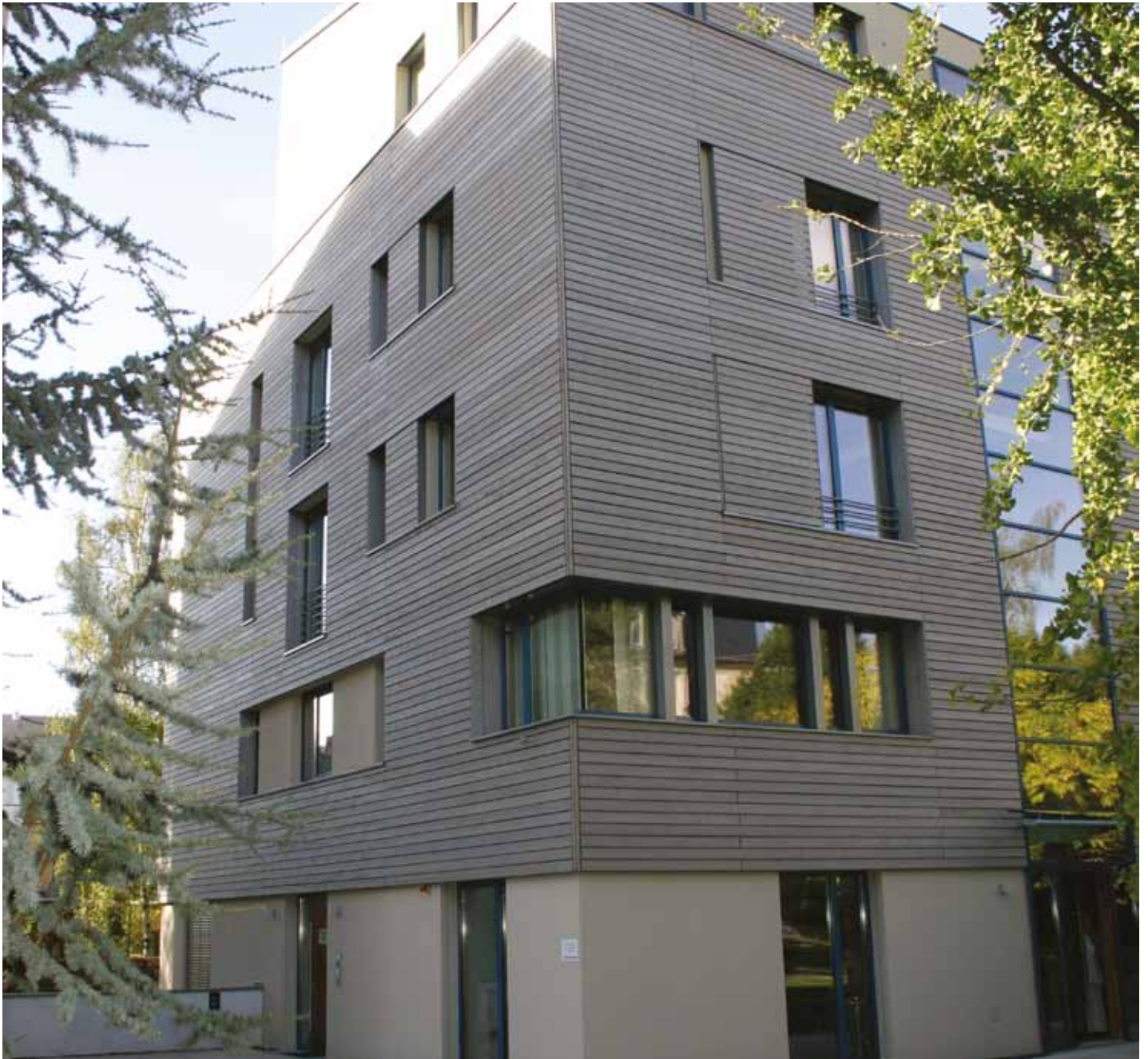
Schwesternhaus Ste Thérèse-ein umweltfreundlicher Massivholzbau
